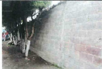
Foto 4: Repello y alizado de pared en muro perimetral
