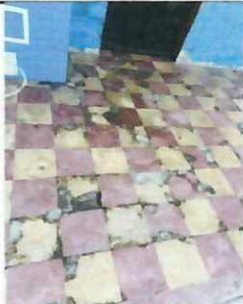
Foto1: Instalación de piso cerámico en módulo de tercer grado
