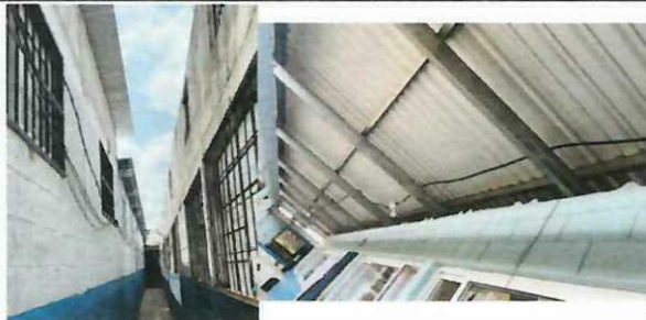
Foto 3: Mantenimiento y corrección de cableado eléctrico módulo de quinto grado
